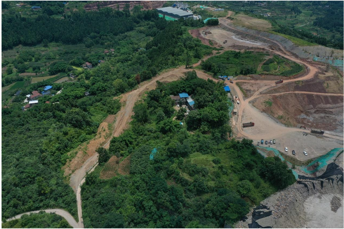
矿区外消防应急演练修建通道
